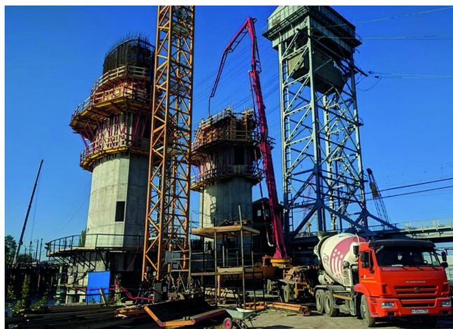
Рис. 6. Конструкция опоры моста первых семи этапов
